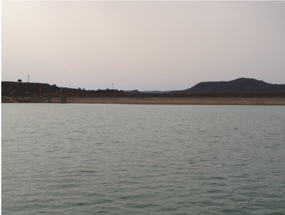
Figura 7. Vista de la presa del embalse
