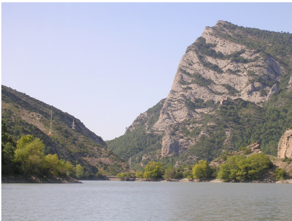
Figura 7. Vista de la presa del embalse
