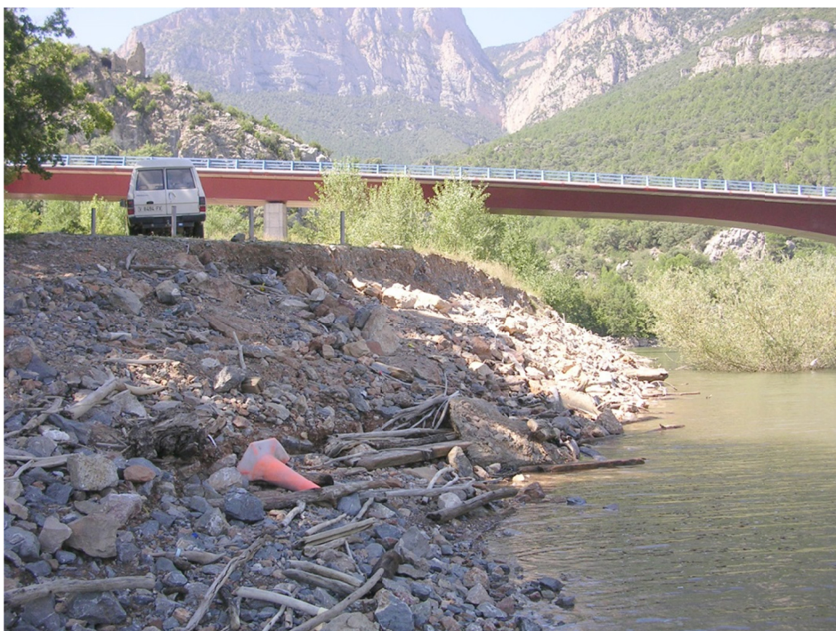
Figura 8. Vista del punto de acceso
