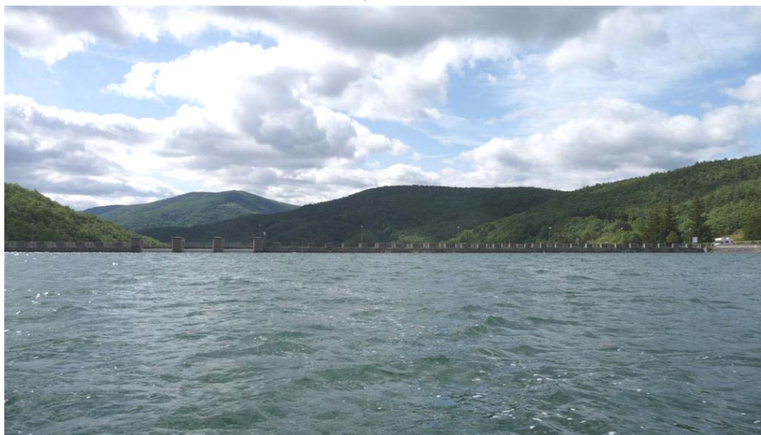
Foto 2: Presa del embalse de Ortigosa
