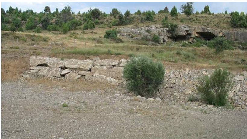
Figura 44-36. Pequeña escollera en el entorno de Cincorres.
