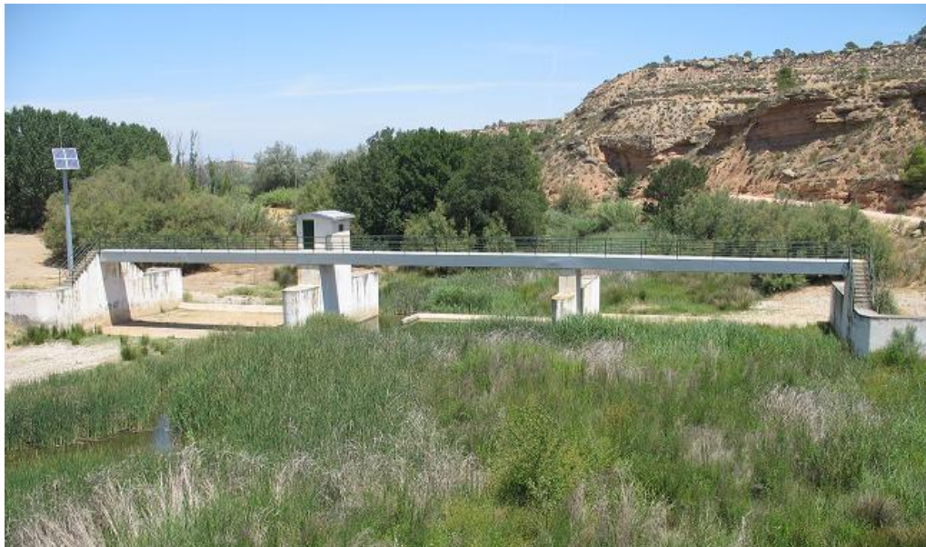
Figura 44-22. Estación de aforos en la parte baja de la masa de agua.
