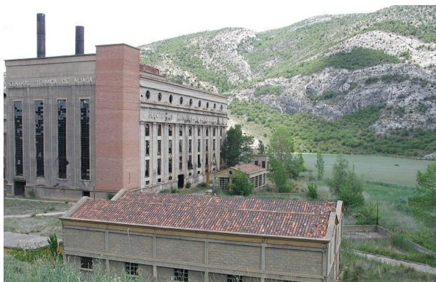
Figura 44-4. Embalse y central térmica de Aliaga.
