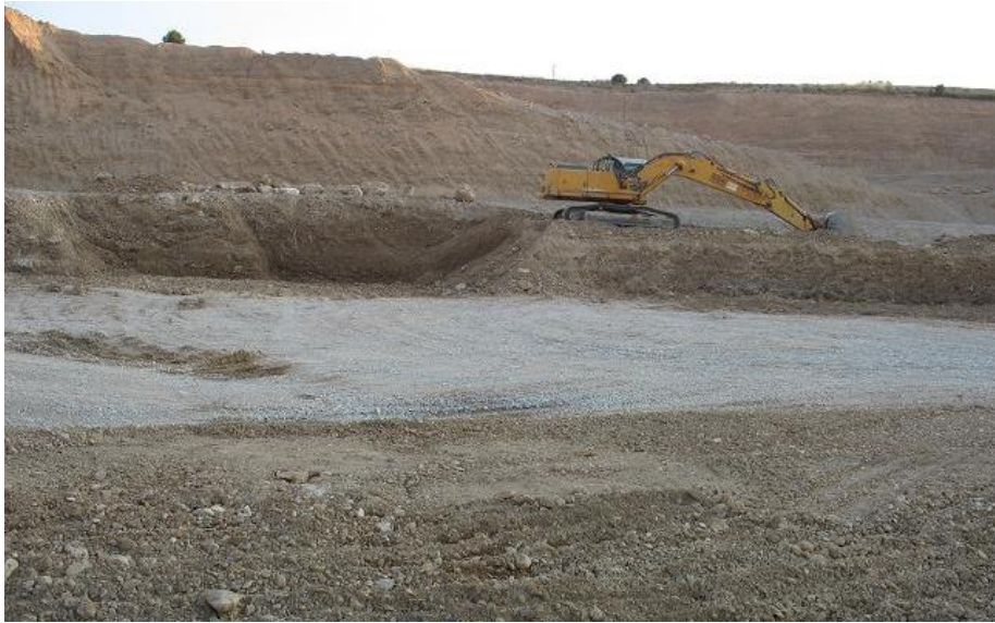
Figura 44-32. Extracción de áridos en Aguaviva.
