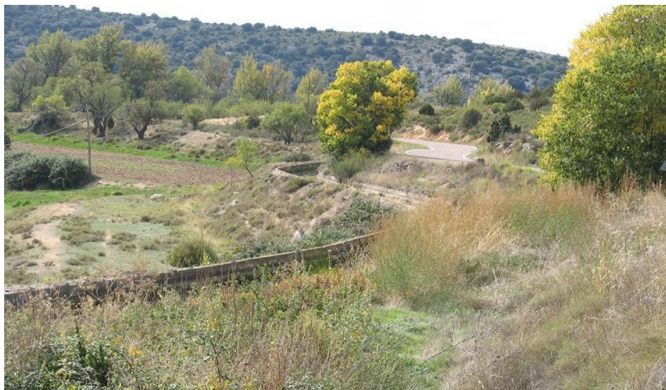
Figura 41-4. Canal de derivación aguas arriba del Monasterio de Piedra.
