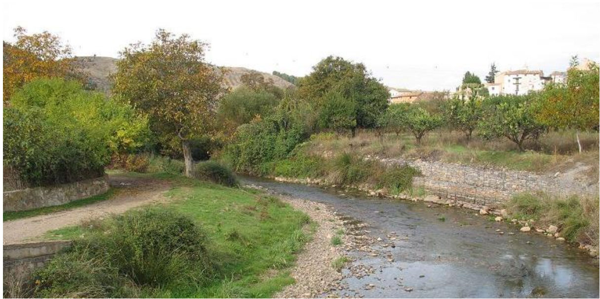
Figura 41-9. Gavión en el entorno de la localidad de Carenas.
