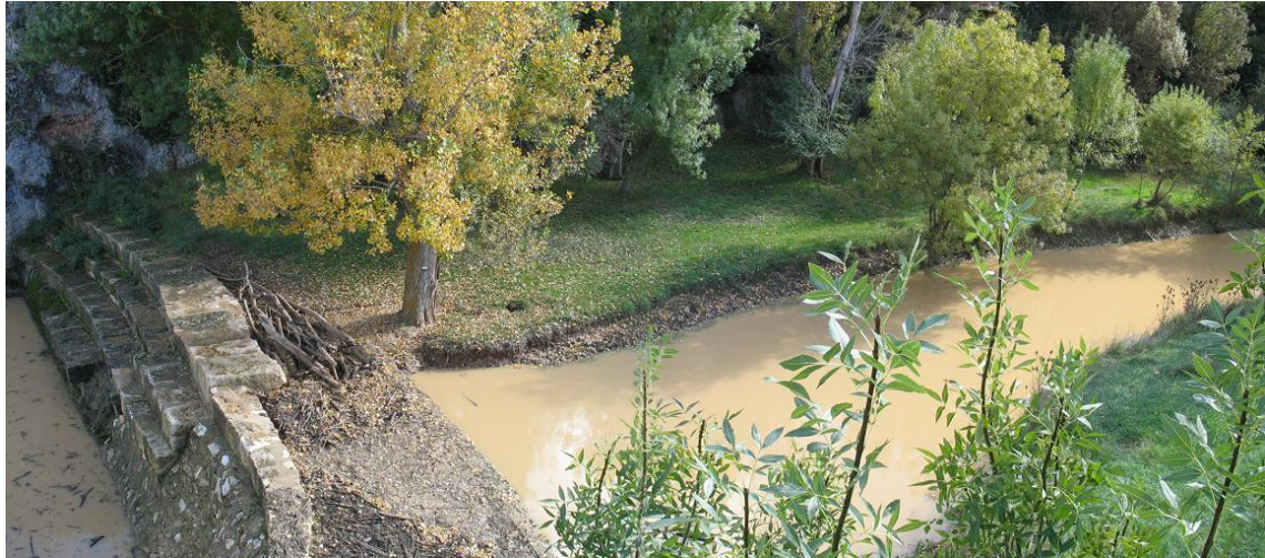
Figura 41-5. Azud colmatado en el entorno de Torralba de los Frailes.
