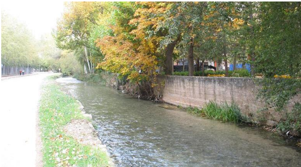
Figura 41-12. Canalización del río Mesa.
