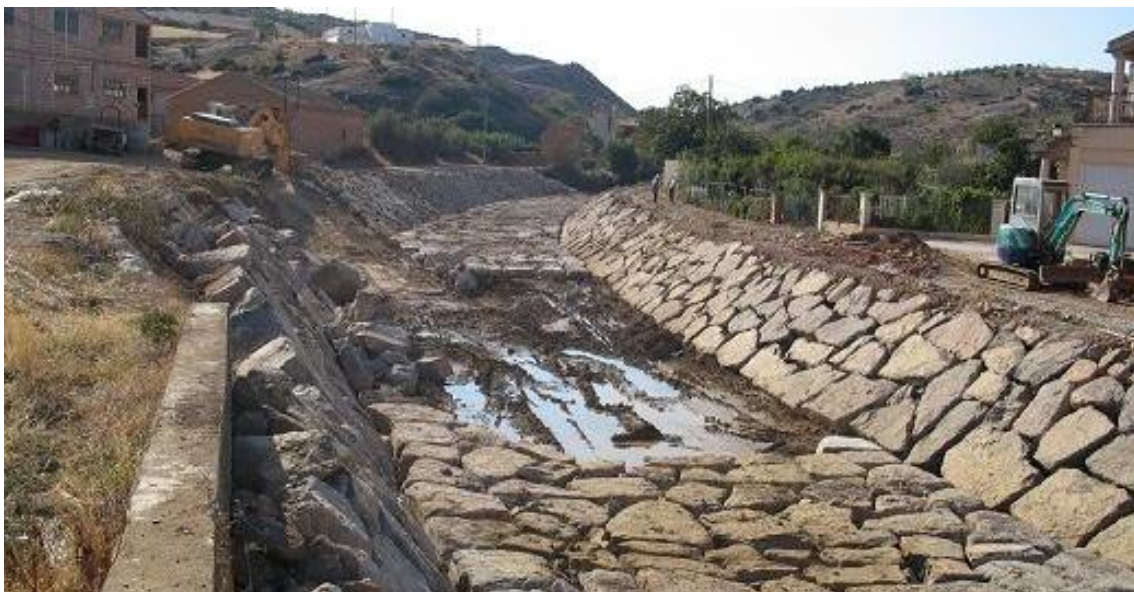
Figura 38-16. Obras de canalización del cauce del río Herrera aguas arriba del núcleo urbano de Herrera de los Navarros.
