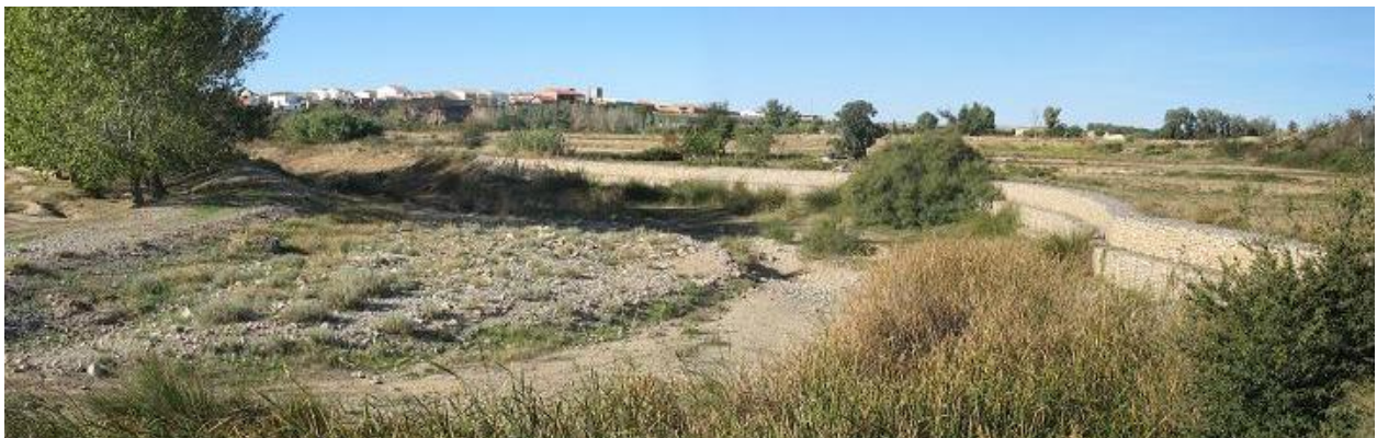
Figura 38-8. Gaviones laterales en las inmediaciones de la localidad de Vinaceite.
