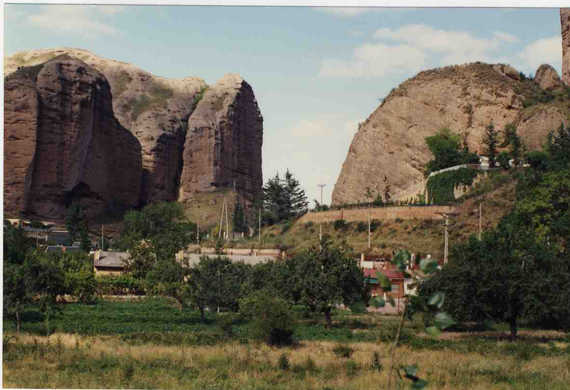
Foto nº 36 Construcciones anárquicas en el estrecho de Islallana.
