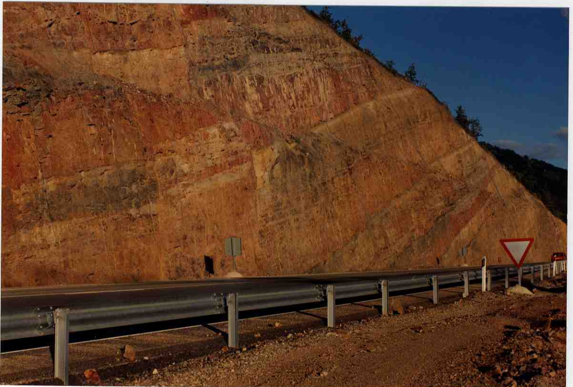
Foto nº 13 Dolominas masivas. Presa de Pajares. Piqueras
