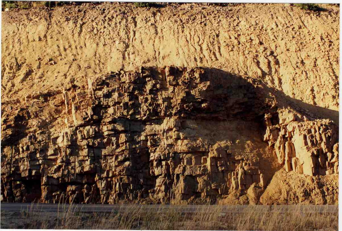
Foto nº 12 Calizas tableadas en proceso de edificación. Piqueras
