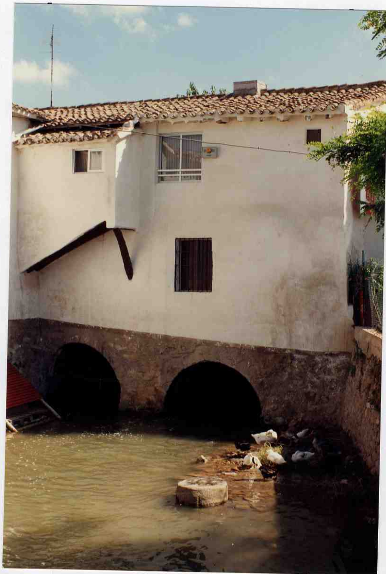
Foto nº 6 Molino rehabilitado. Nalda
