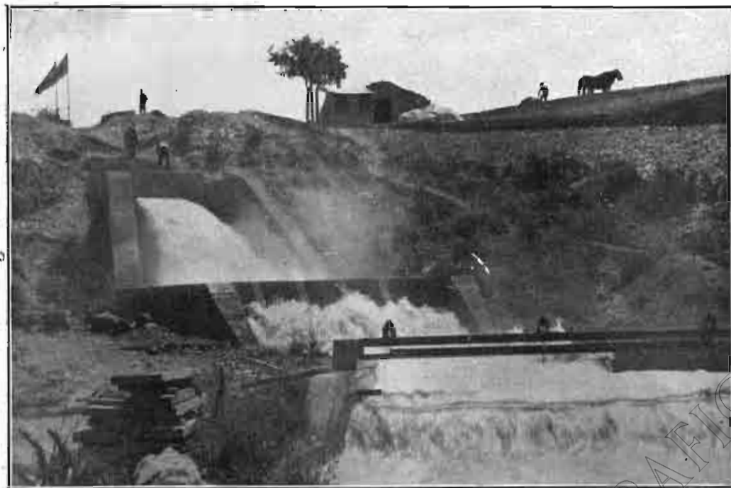
DESAGÜES AL RÍO SIGRE EN EL FINAL DEL CANAL DE CONEXIÓN Y ALIMENTACIÓN REGULADA DE LA ACIQUA DEL COMPTON
