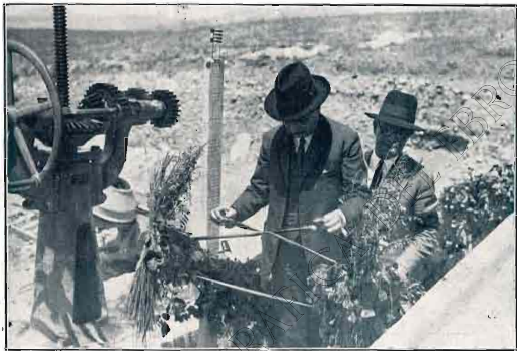
MECANISMOS DE MANIOBRA DE LA COMPUERTA SITUADA EN LA CABEZA SUPERIOR DEL SIFÓN DEL SIÓ
