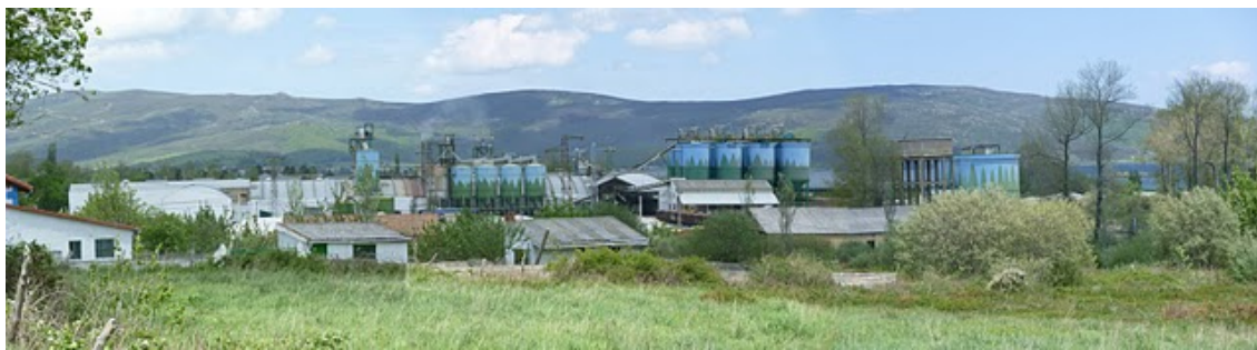
Ilustración 28: Vista general de una planta de tratamiento
