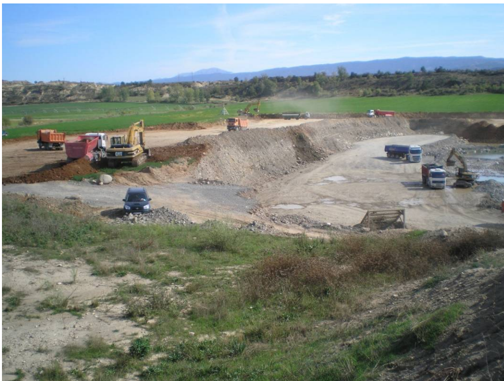
Ilustración 7: Gravera activa simultaneando actividades de rehabilitación y explotación
