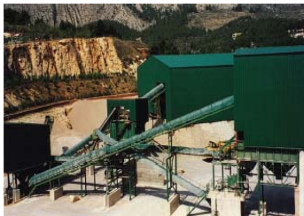
Ilustración 68: Carenado de las instalaciones
