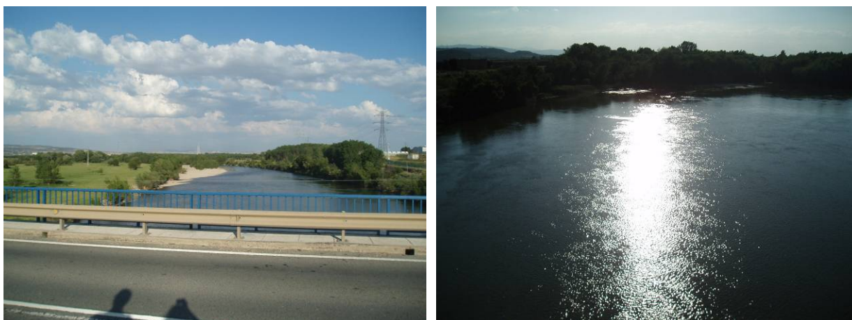
Ilustración 35: Acumulación de gravas en el Ebro a su paso por Castejón
