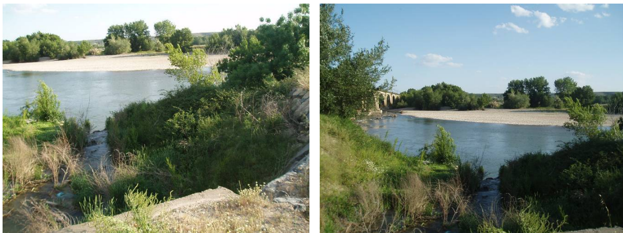
Ilustración 34: Acumulación de gravas bajo el puente del ferrocarril. Tramo del Ebro entre el río Alhama y el Queiles
