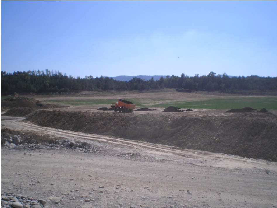
Ilustración 22: Movimiento de tierras
