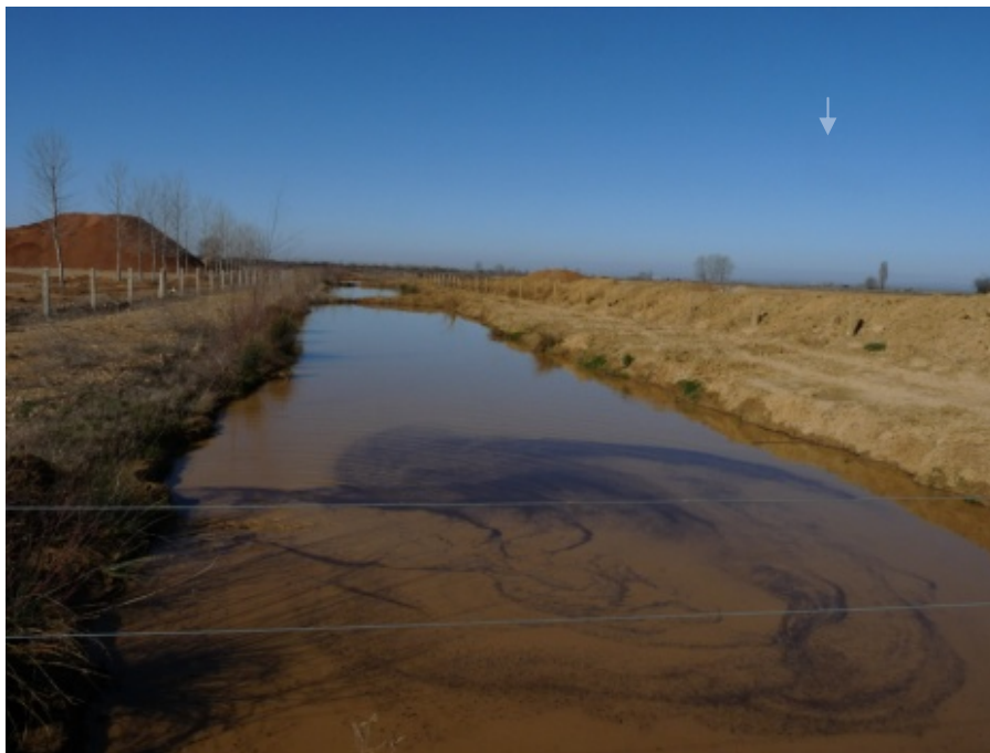
Ilustración 40: Balsa decantación de lodos
