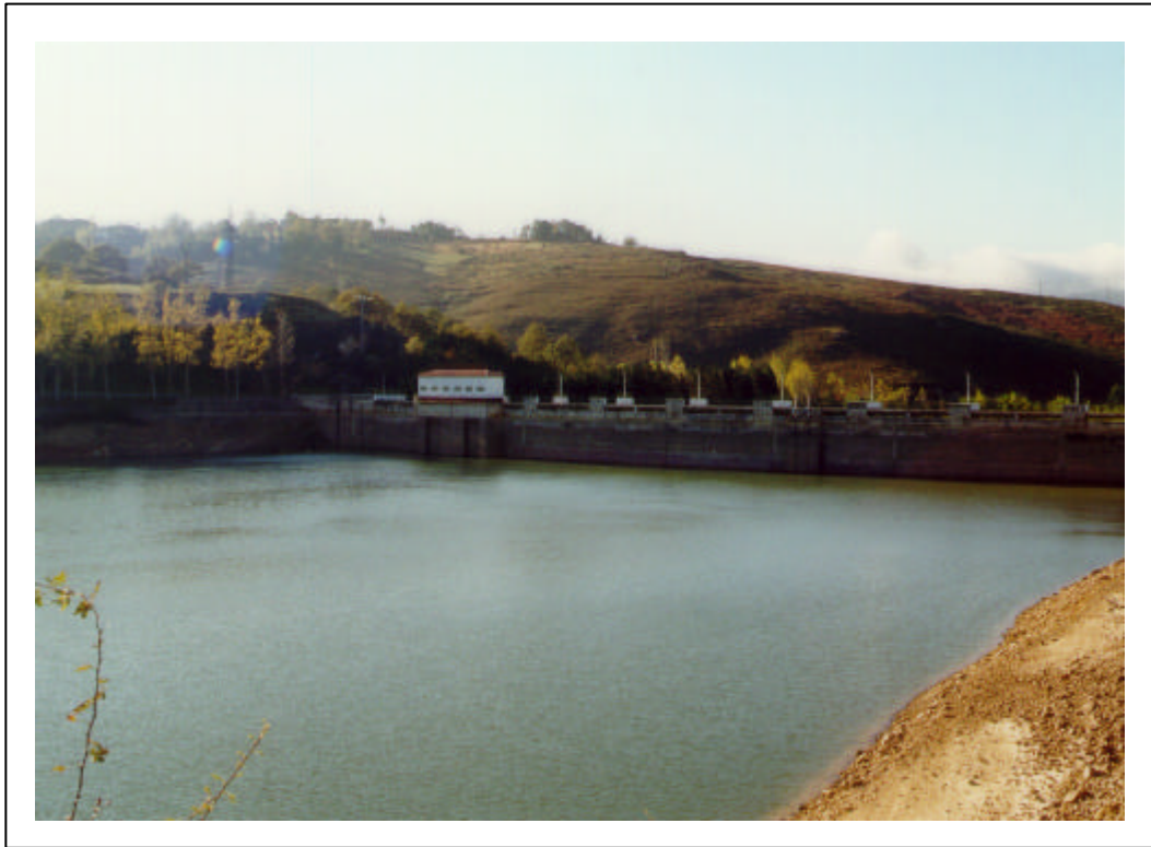
Foto 1. Vista de la presa del Ebro, en octubre del 2001.
