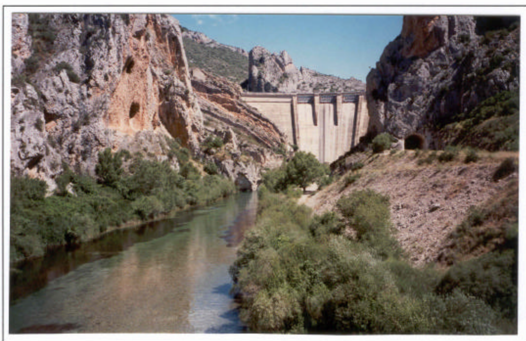
Río Noguera Ribagorzana aguas abajo de la presa.
